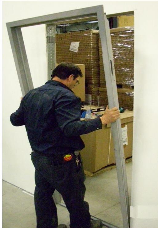
Figure 6 : Cadre positionné dans l'ouverture
