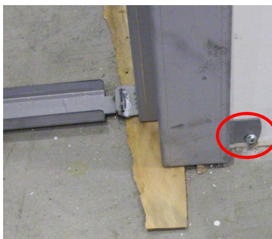
Figure 8 : Ancrage en L vissé au mur
