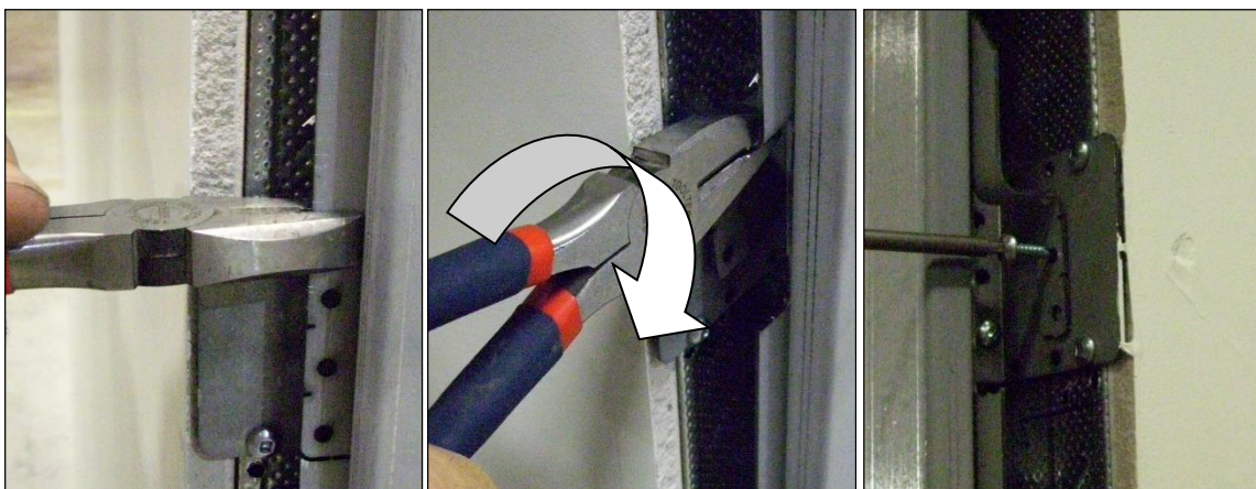
Figure 9 : Plier et visser la languette
